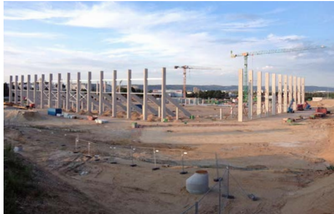
Abb. 3: Das neue Jahnstadion im Bau
